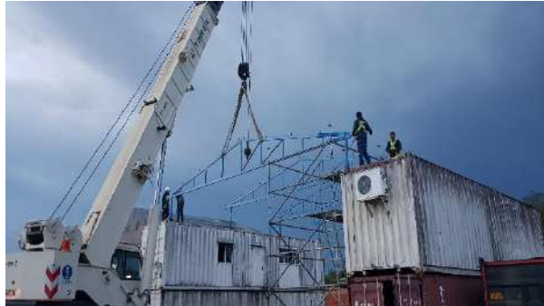
FABRICACIÓN DE ESTRUCTURAS
